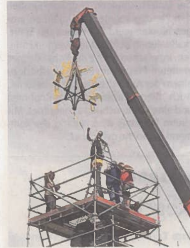
Der Autokran hebt das Kreuz auf die Spitze des Kamper Hofes. RP-FOTO: A. FISCHER
